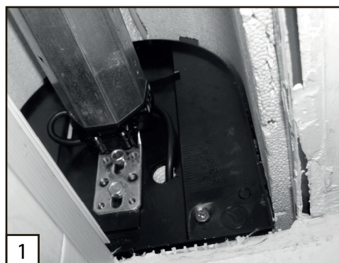
Stap 1: Monteer eerst de motor in de rolluikkast
