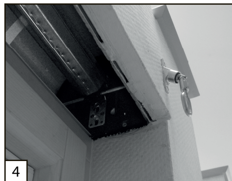
Stap 4: Monteer nu de plaat van het oogwindwerk op de muur
