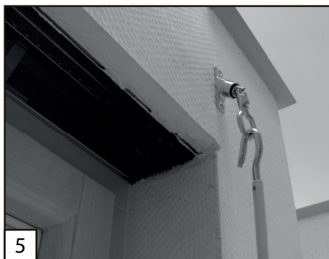
Stap 5: Klaar! U kunt nu de slingerstang aanhaken en in het geval van stroomuitval de motor handmatig bedienen.
