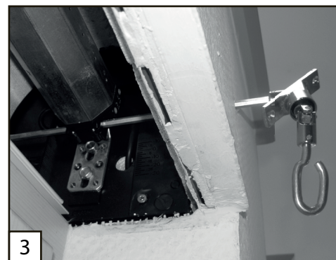
Stap 3: Steek nu het oogwindwerk door de motorkop van de motor
