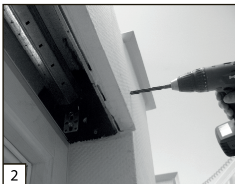
Stap 2: Boor nu het gat voor het oogwindwerk
